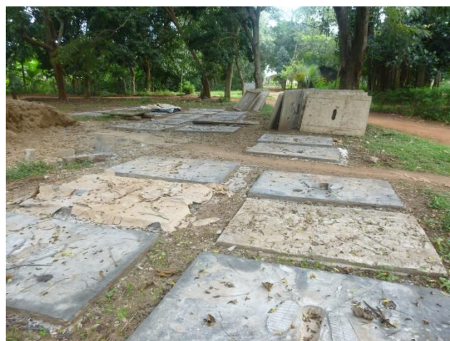
Bodenplatten für die Latrinen
